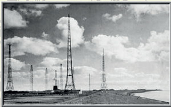
Alte Empfangs- und Sendefunkstelle in Norddeich aus Gründerzeiten (heute Campingplatz (ohne Masten))
